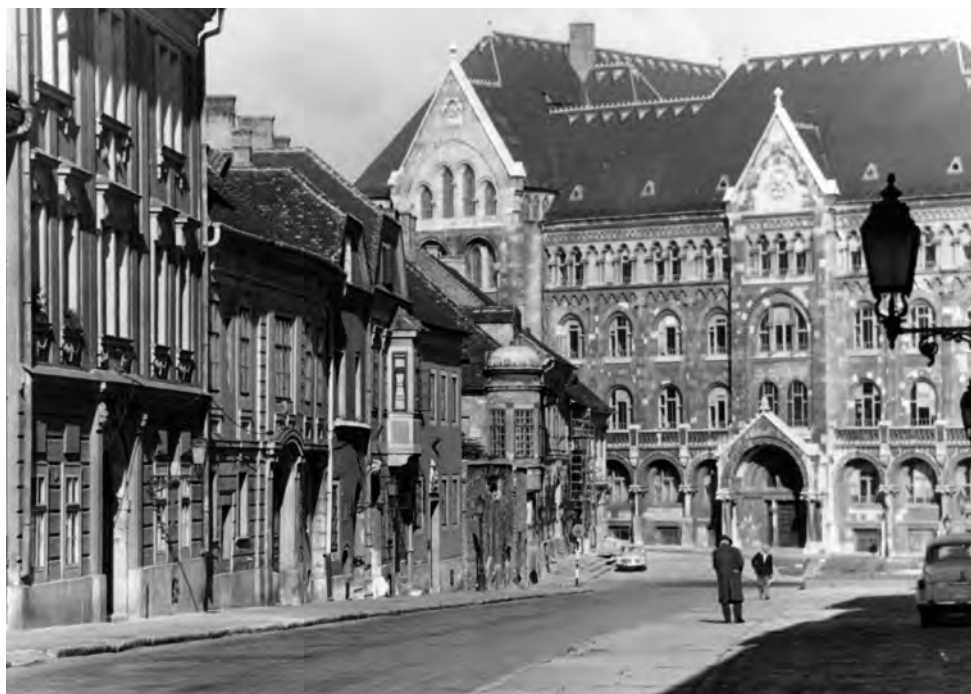
A levéltár épülete a Fortuna utca felől, 1967
